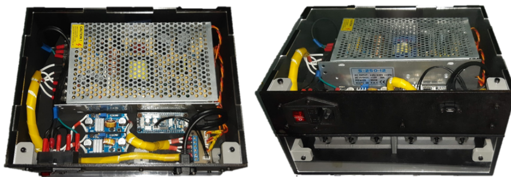
Figura 95: Vistas del montaje de los módulos y conexión eléctrica.
