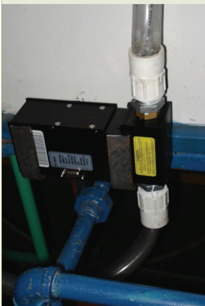
► Figura 6. Válvula para el control del flujo de gas
