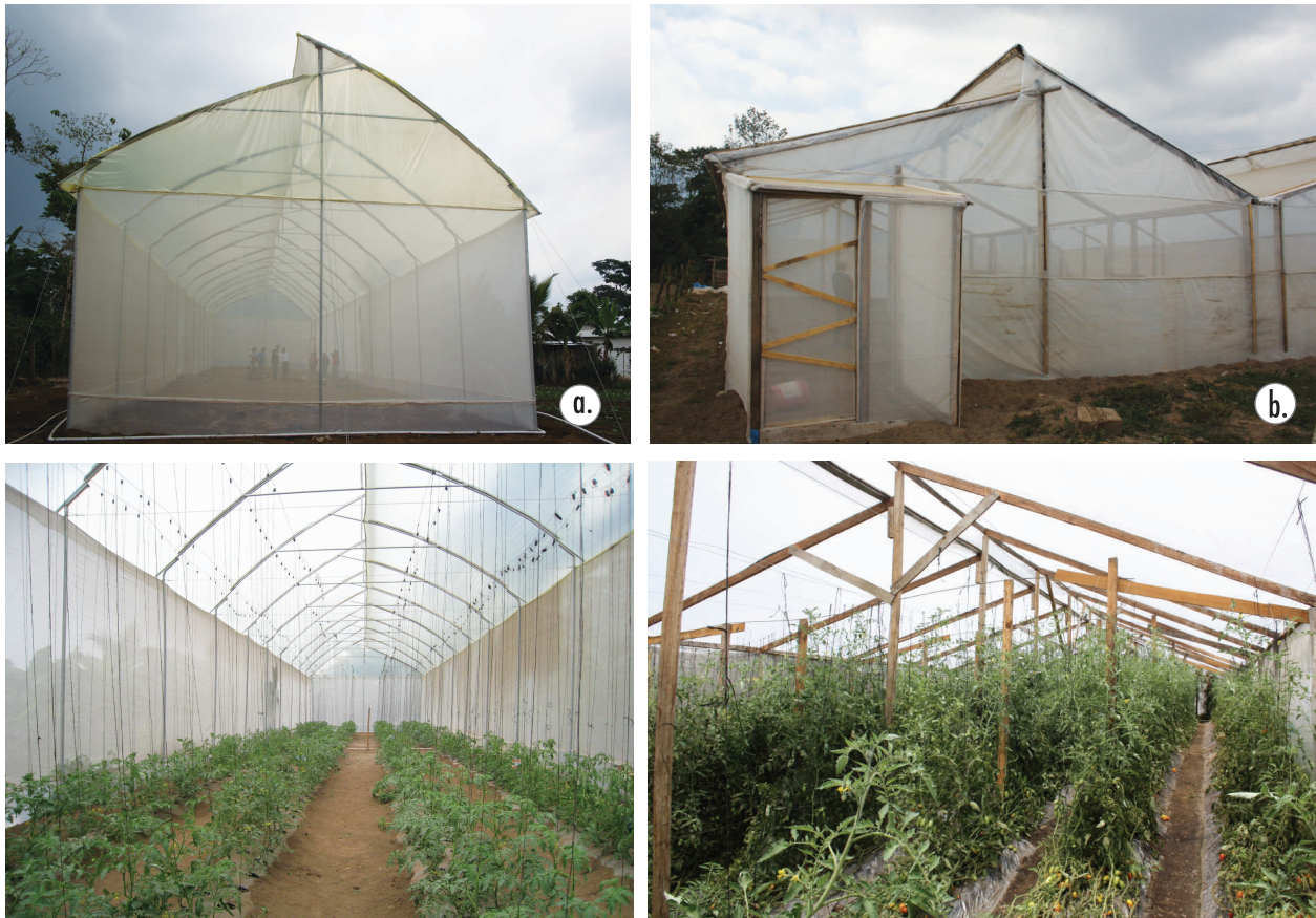
Figura 1. Ejemplo del tipo de invernaderos de madera (a) utilizados por pequeños productores y de hierro galvanizado (b) instalado para el estudio.
