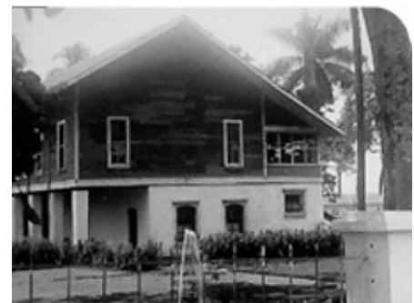
Imagen 2. Finca Pantaleón oficinas y planta
