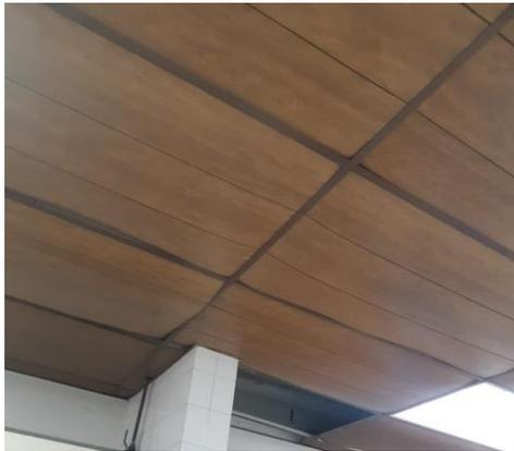
*Imagen 5 Cielo falso en malas condiciones.*
