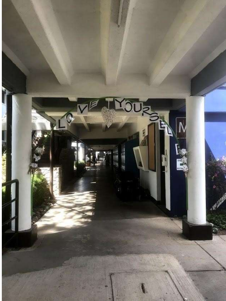
Figura 3: Pasillo de entrada a edificio C (Fotografía tomada en visita)
