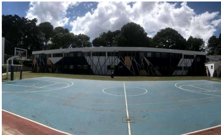
Figura 2: Fachada de edificio C(Fotografía tomada en visita)
