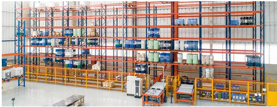
Figura 4: Bodega con transelevador de MECALUX [5].
