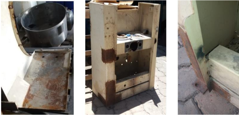
Figura 15: Chasis con reparaciones realizadas de la primera lavadora de muestras
