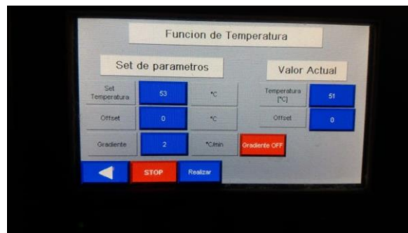
Figura 54: Función de calentamiento del sistema
