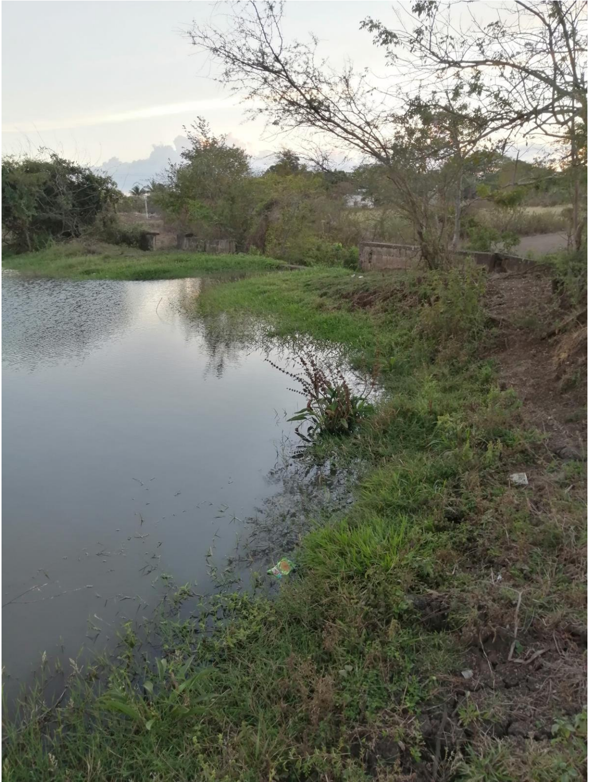
Figura 53. Anexo 2 - Ejemplo de laguna artesanal para captar el agua de lluvia
