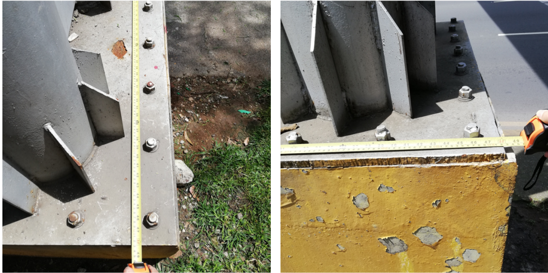
Figura 90: Dimensión de pedestal de concreto de pasarela
