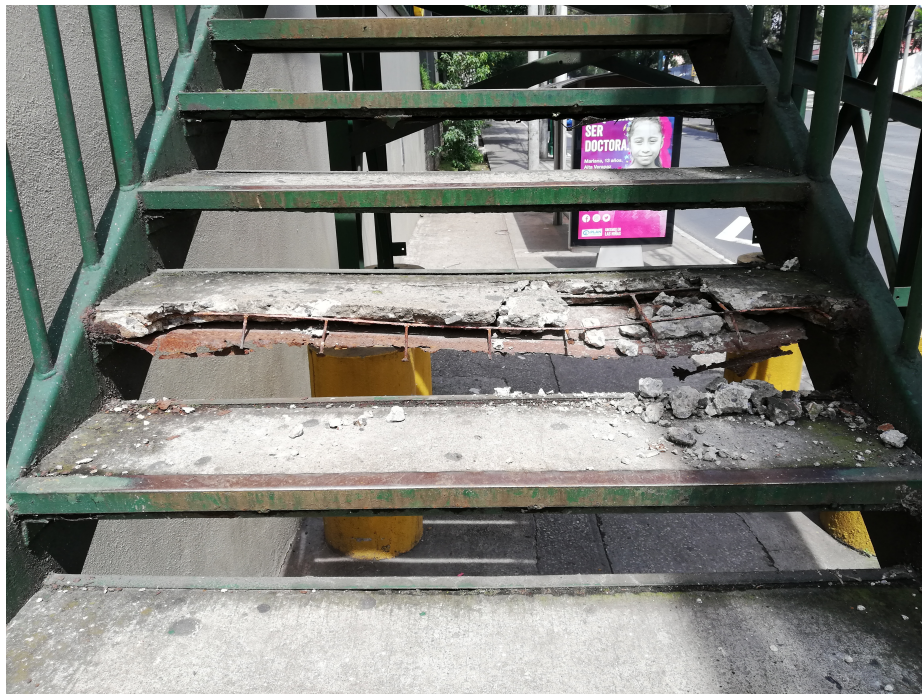
Figura 91: Gradas pasarela verde
