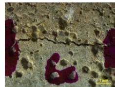
Figura 283: Grieta C del cubo 3 cepa P.5.2.A sin medio de precipitación
