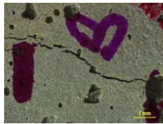
Figura 298: Grieta B del cubo 2 cepa P.5.3.A sin medio de precipitación
