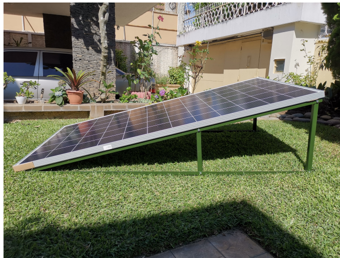
Figura 42: Ensamble de estructura al panel solar
