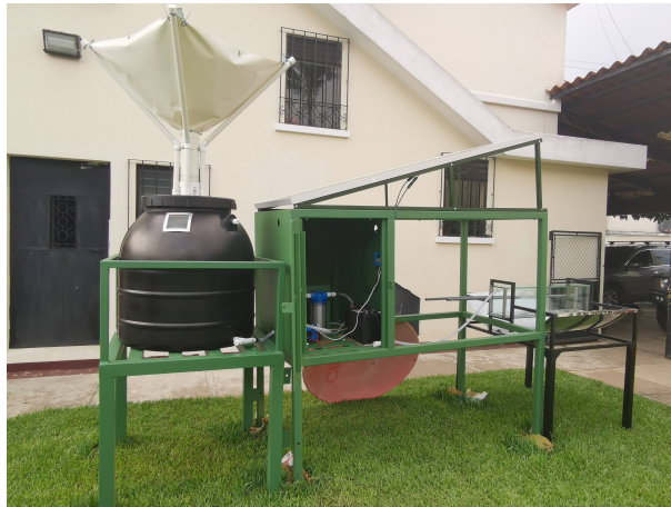
Figura 48: Resultado final del sistema de colección de agua de lluvia y sistema de bombeo
