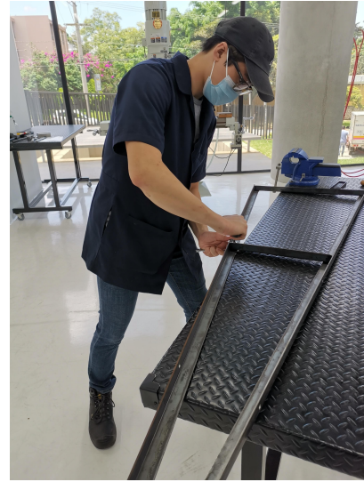
Figura 41: Atornillado de angulares
