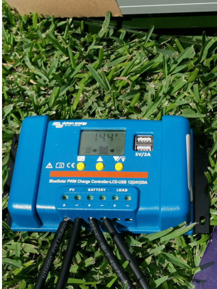
Figura 43: Lectura de voltaje de la batería de carro
