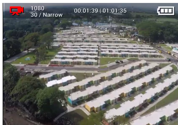
Figura 60: Segundo vuelo de inspección de área
