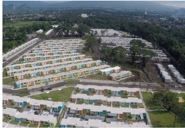
Figura 51: Vuelo de inspección de obra La Dignidad
