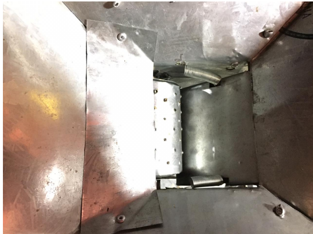
Figura 5.12: Salida del silo vista desde adentro del silo.
