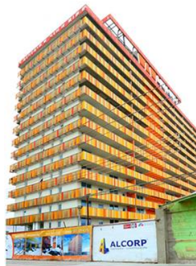
Figura No. 55 Edificio Torre del Sol
