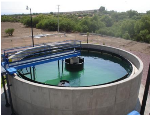
Figura 87. Tanque clarificador
