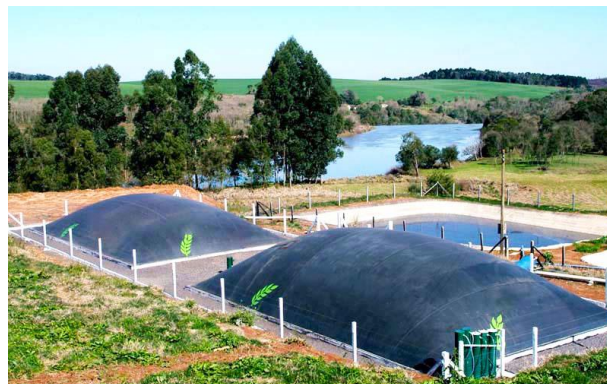
Figura 84. laguna anaerobia
