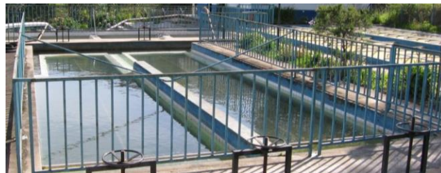
Figura 80. Tanque sedimentador
