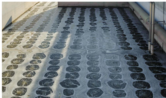
Figura 86. Tanque de reducción de nutrientes
