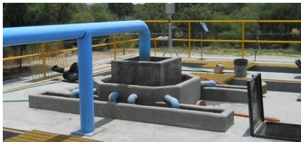
Figura 82. Filtro anaerobio de flujo ascendente
