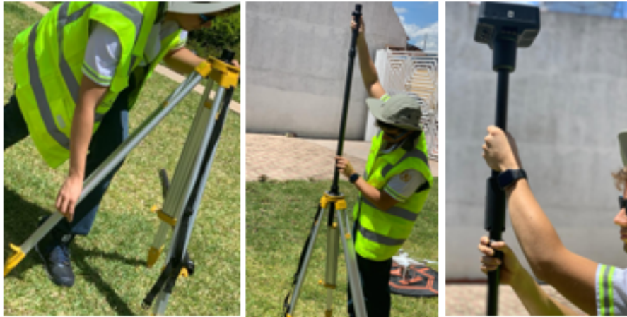
Figura 16: “Nivelación y armado de la estación móvil D2-RTK”
