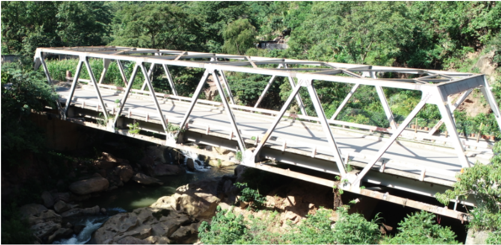
Figura 78: Anexo 25 - “Puente de armadura metálica presente en subtramo número 3”
