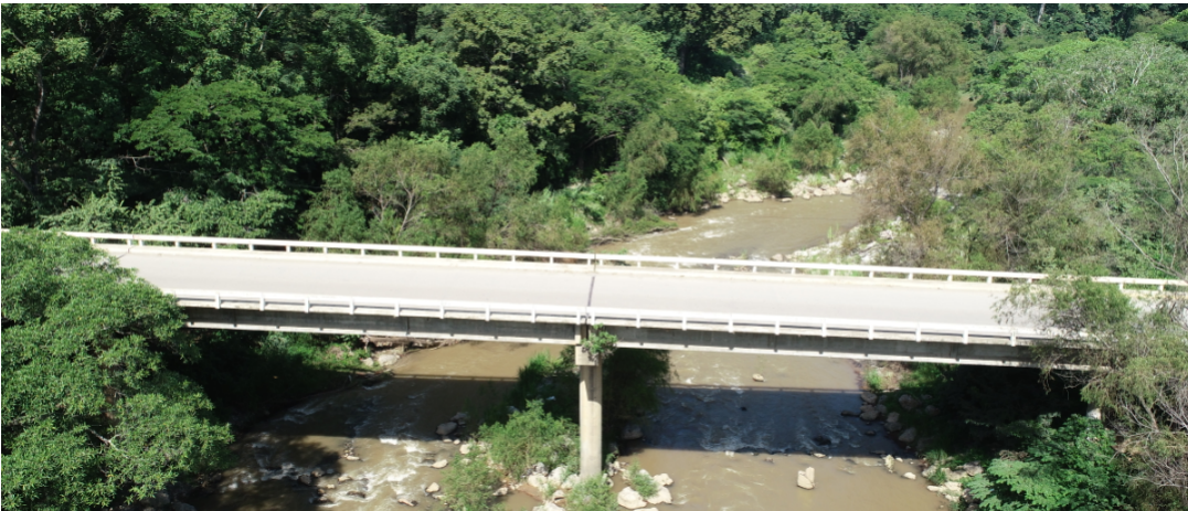
Figura 79: Anexo 26 - “Puente de concreto presente en subtramo número 11”
