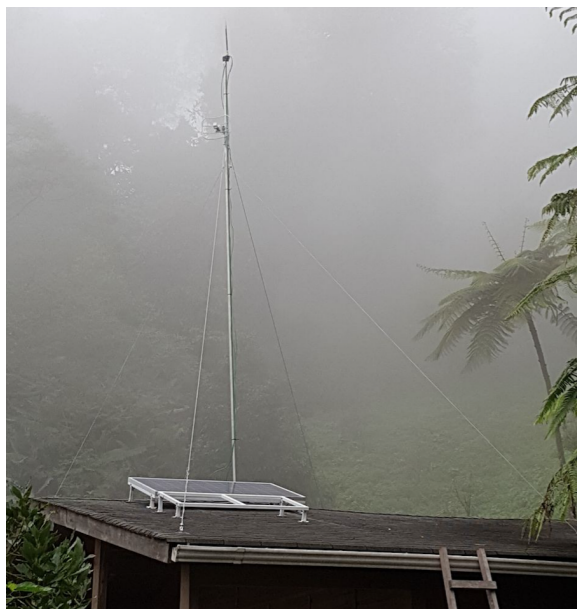
Figura 32: Instalación de SPCR en Reserva UVG
