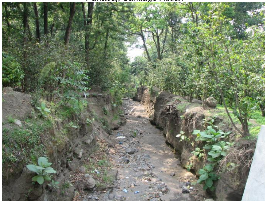
FOTOGRAFÍA No. 49: Brecha que se abrió para drenar el aumento de lluvias provocadas por el Stan Panabaj, Santiago Atitlán
