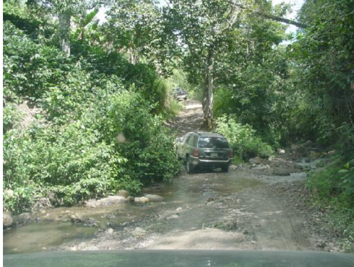
FOTOGRAFIA No. 30: Carretera no asfaltada en Zacapa
