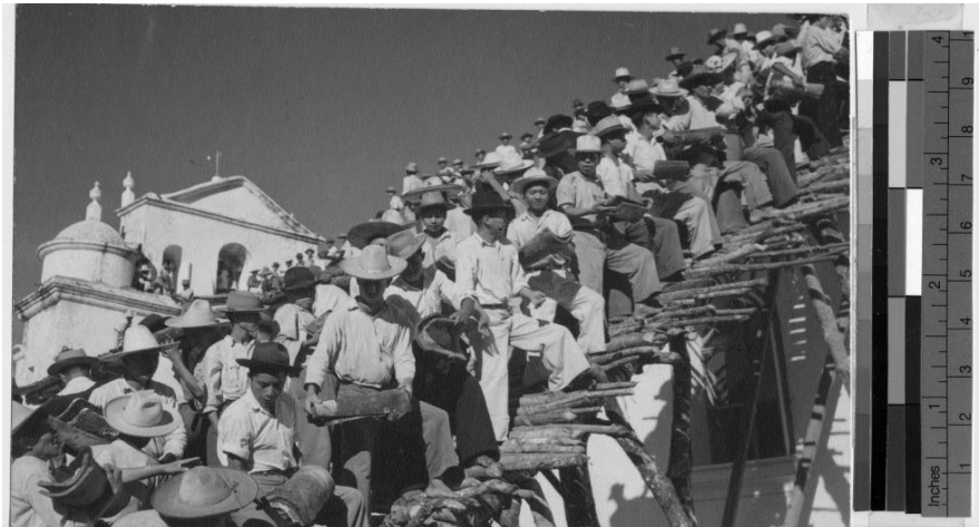
Fotografía 3:Hombres cambiando el techo de la Iglesia de Jacaltenango,1947.
