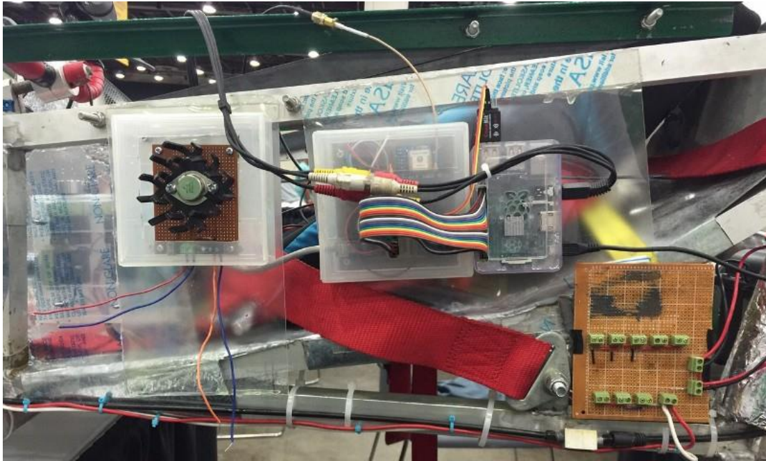
Figura 49: Módulo de sensores fase I instalado en el automóvil. Primero se aprecia el módulo de regulación, luego el módulo de interconexión y por último el módulo Raspberry.
