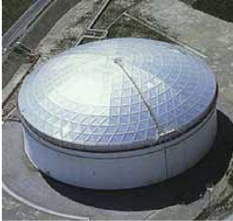
Figura No. 15: Tanque con techo de sombrilla (nótese los quiebres en el domo)
