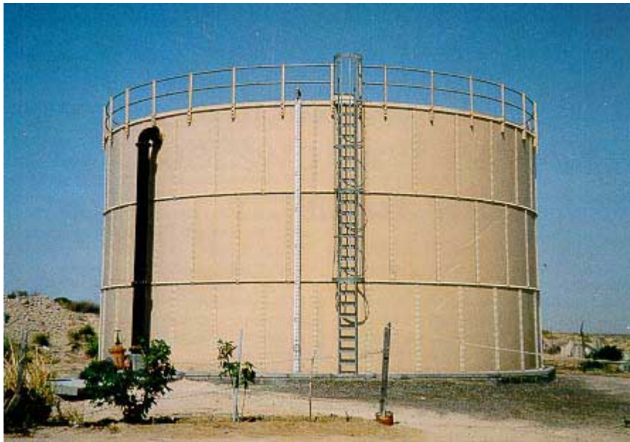
Figura No. 9: Tanque atmosférico
