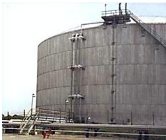
Figura No. 12: Tanque refrigerado
