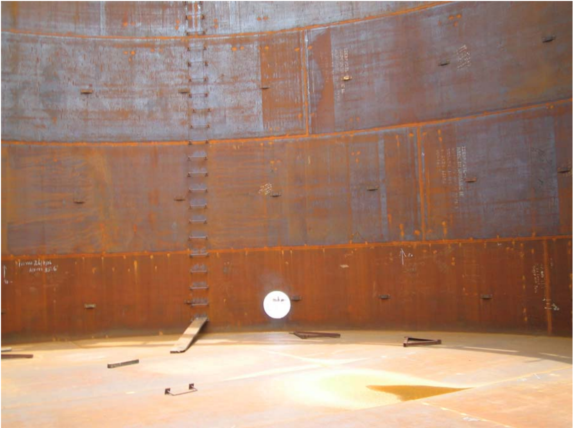
Figura No. 2: Vista de la pared desde el interior de un tanque
