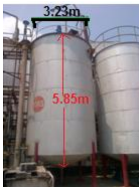
Imagen No.8: Parte exterior tanque 1003 y localización
