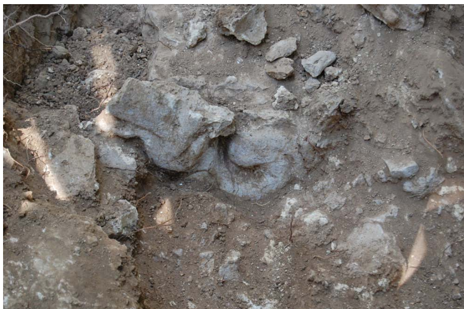
Figura 13. Detalle de la decoración de estuco en la fachada principal de la Estructura 13R-3
