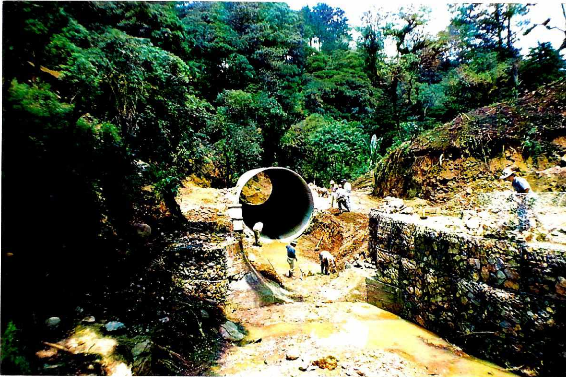
Muro de gaviones.
