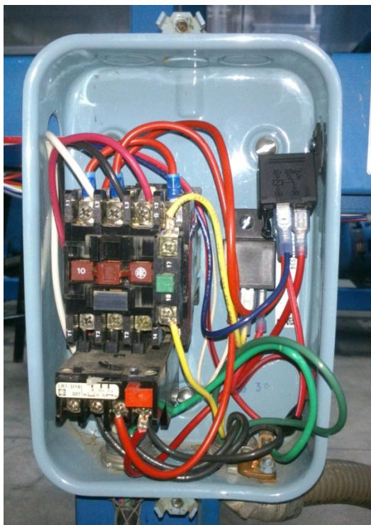
Figura 35 Relés para controlar bobina del contactor del ventilador
