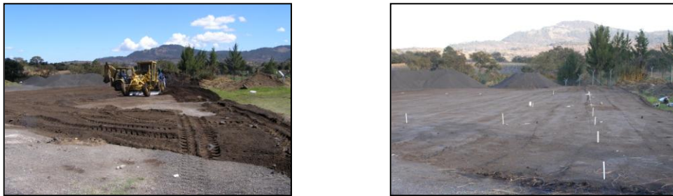
Figura 4. Preparación y apariencia final de la plataforma para colocar pilas de compostaje.
