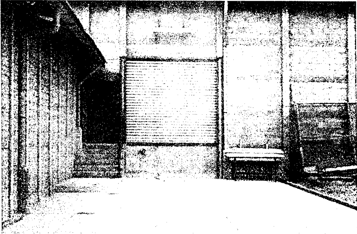
Vista frontal del área para carga y descarga de materia prima.
