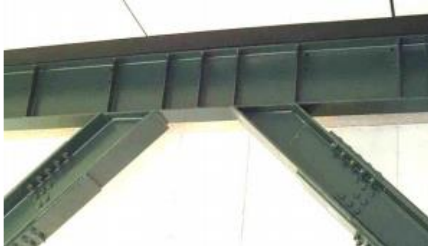
Figura 24. Detalle del enlace de un marco excéntrico
