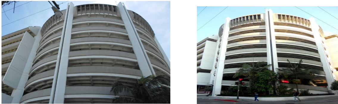
Figura 28. Vista frontal y lateral de torre de estacionamientos 5ta calle y 11 Av. zona 1
