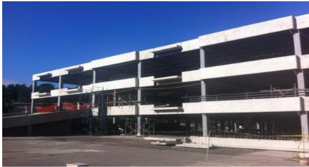
Figura 21. Edificio de estacionamientos en construcción
