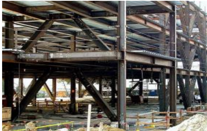
Figura 23. Marcos con arriostramientos excéntricos
