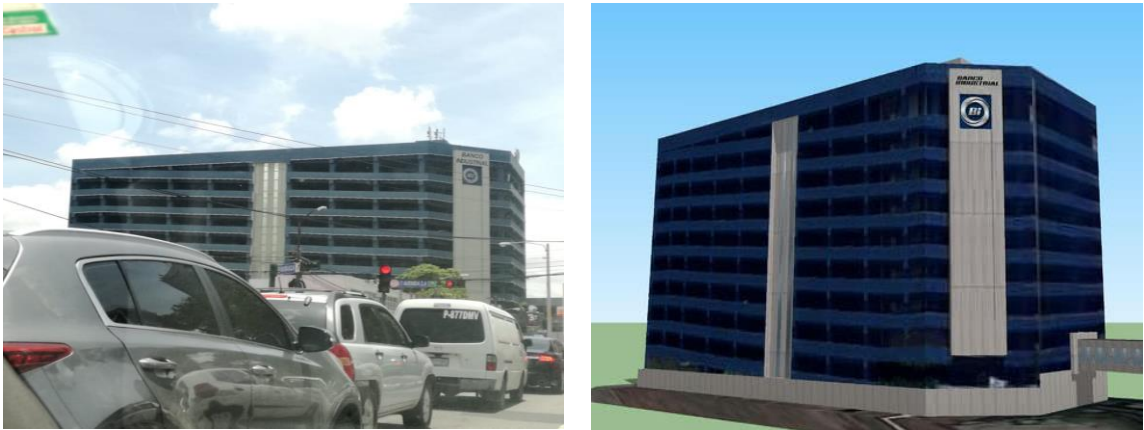
Figura 31. Torre de estacionamiento Banco Industrial zona 4
