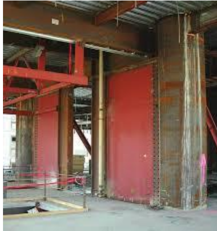
Figura 10. Edificio con muros de corte de acero.
