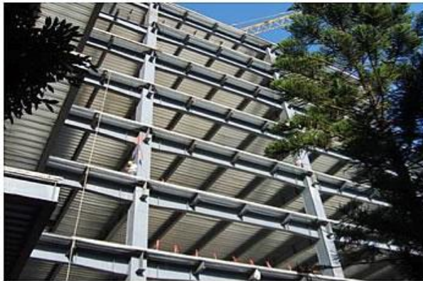
Figura 9. Edificio de marcos rígidos en acero
