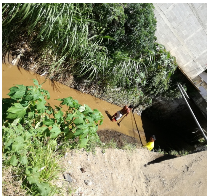
Imagen 16: Trabajos de limpieza del río Pensativo
