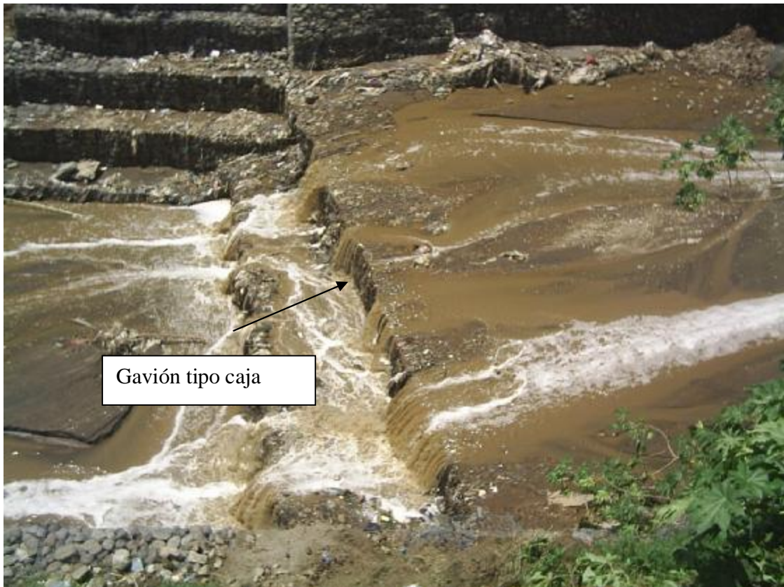
Figura 4.33 Losa hecha con gavión tipo caja en sustitución a la de concreto dañada
