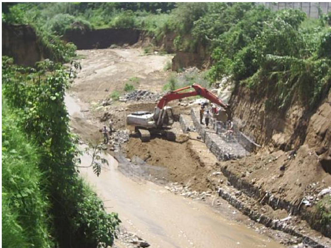
Figura 4.29 Llenado del gavión utilizando la excavadora
