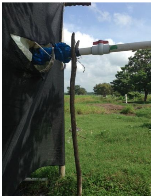
Ilustración 50: Salida de biogás de bolsa contenedora.
