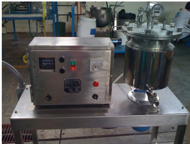
Ilustración 25. Reactor químico y variador
