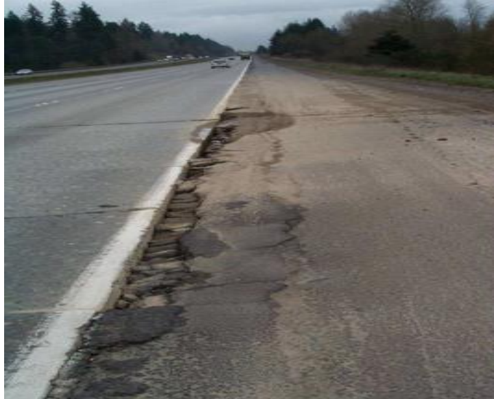
Ilustración 7: Grietas logitudinales
