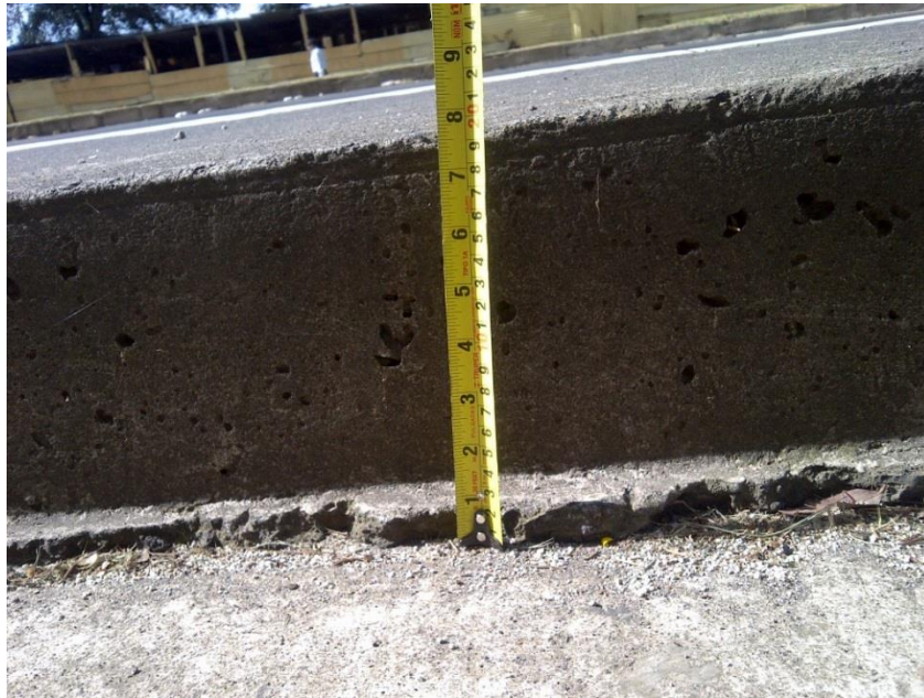
Ilustración 64: Espesor de losa 20 cm.
