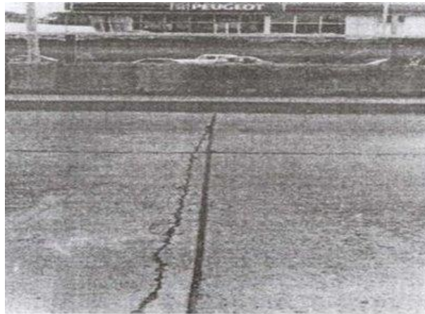
Ilustración 8: Grietas transversales
