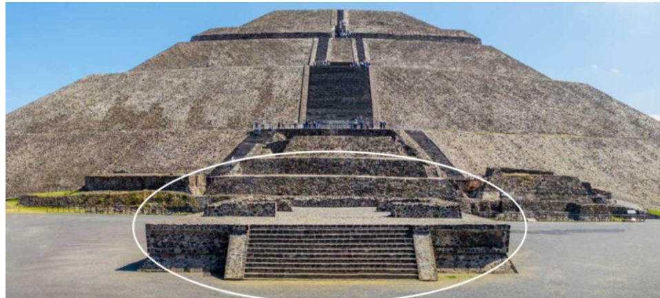
Figura 49. Estructura talud-tablero de Teotihuacan (circulado en blanco)
