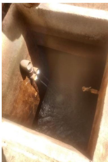
Ilustración 27. Sistema de almacenamiento y distribución de agua en tanque principal de almacenamiento
