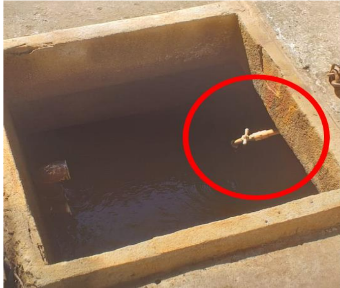
Ilustración 13. Tanque de cloración artesanal sistema No. 2
