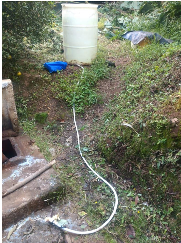
Ilustración 13. Tanque de cloración artesanal sistema No. 2
