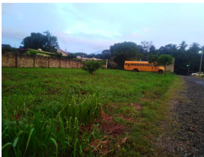
Figura 20: Terreno para construcción
