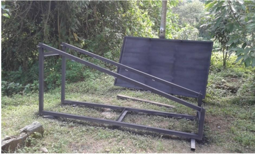
Ilustración 21. Construcción del colector solar
