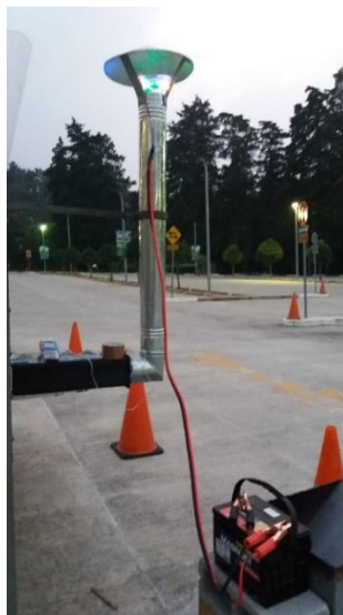
Ilustración 31. Ventilador colocado en la chimenea
