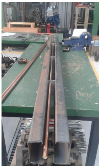
Ilustración 24. Construcción del intercambiador de calor
