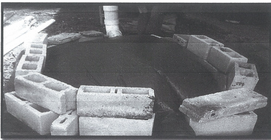
Ilustración 39, Biodigestor operando, Etapa # 1.
