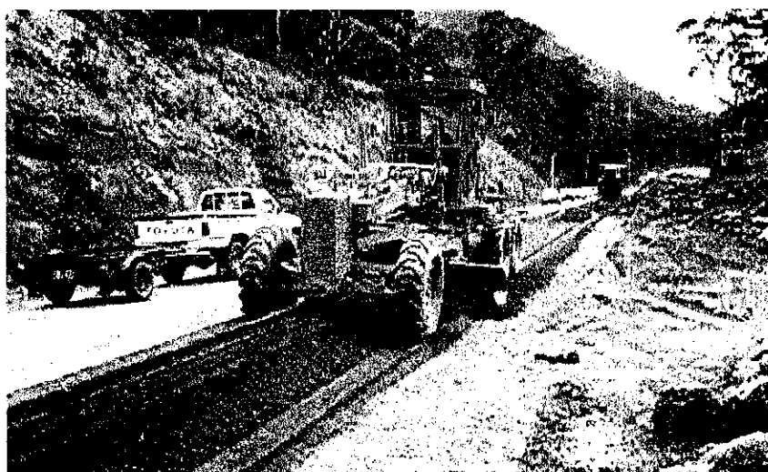
Fig. 1.11 La disgregación del material recuperado se realiza con una motoniveladora, repartiendo, compensando y tendiendo para dejar la mezcla lista para su compactación.
