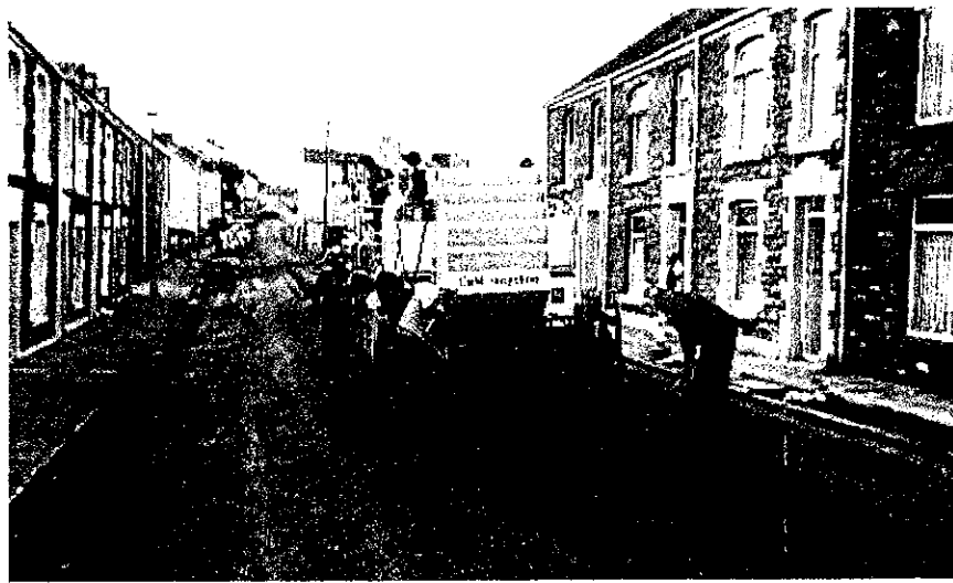
Fig. 1.13 Con la tecnología con que se cuenta hoy en día, el proceso de escarificado, mezclado y tendido se puede realizar con una sola máquina.
