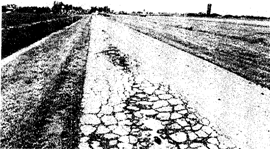
Fig. 1.6 Esta carretera ya no puede brindar un buen servicio por falta de mantenimiento, pero puede ser rehabilitada.
