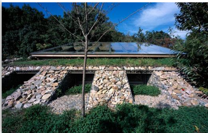
Ilustración 32: Vista del exterior de Base Valley House.
