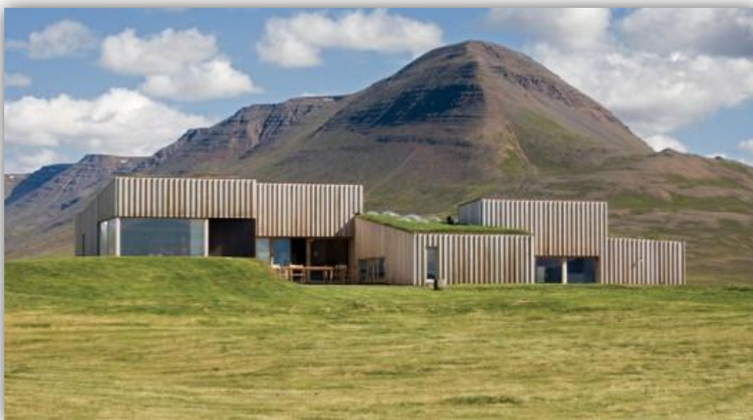
Ilustración 39: Vista desde el exterior de la casa Hof.
