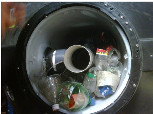
Ilustración 210: Mal diseño de un biodigestor, vista I.
