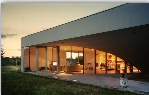
Ilustración 36: Vista de la casa Outrial en Varsovia, Polonia.
