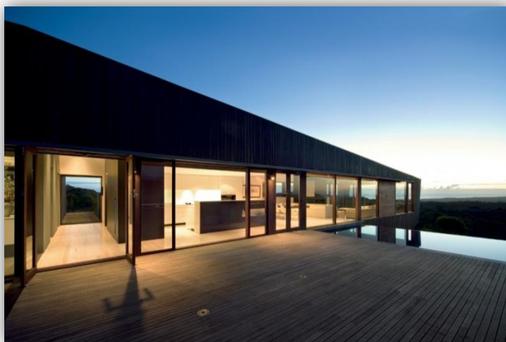
Ilustración 43: Vista de la terraza de la casa de Cape Schanck.
