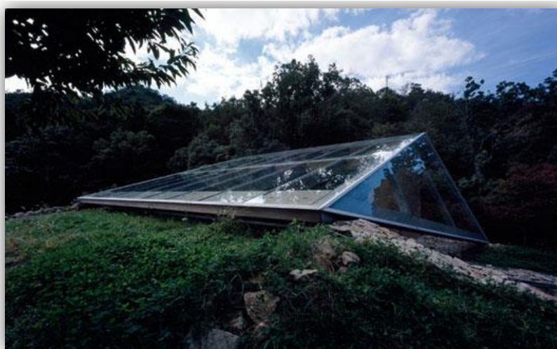
Ilustración 34: Techo de cristal de Base Valley House
