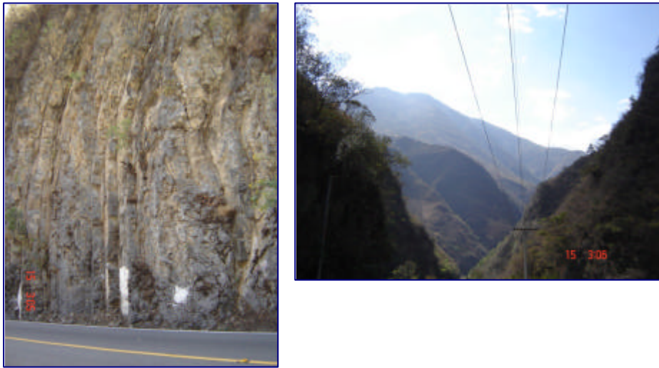
Figura 21. Túnel de Anabella, donde se tomó muestra de agua, coordenadas N: 1706931 E: 0631922. Roca caliza con vetas de cuarzo Mineralizada dentro del túnel.
