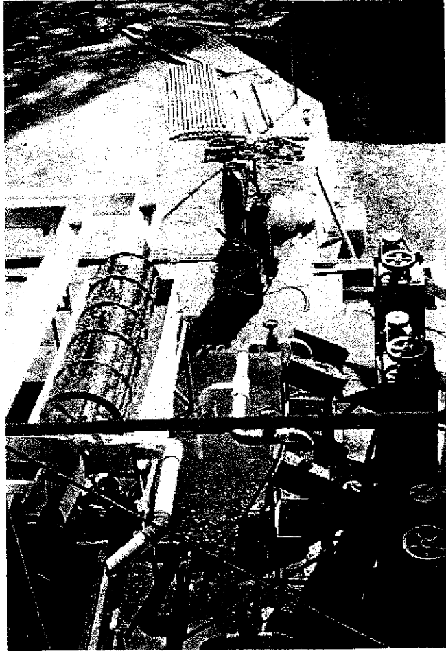
6. Criba y Desmucilagadores en Operación
