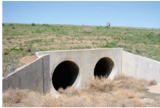
Figura 4: Alcantarilla de sección circular. [5]
