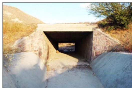
Figura 5: Alcantarilla tipo cajón. [6]
