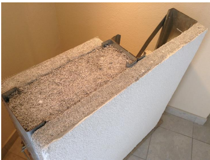
Imagen No. 142: Conexión de Europanel a material estructural.
