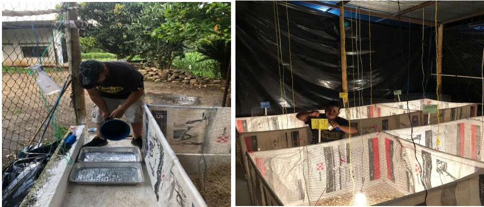
Figura 21. Instalación de pediluvios
