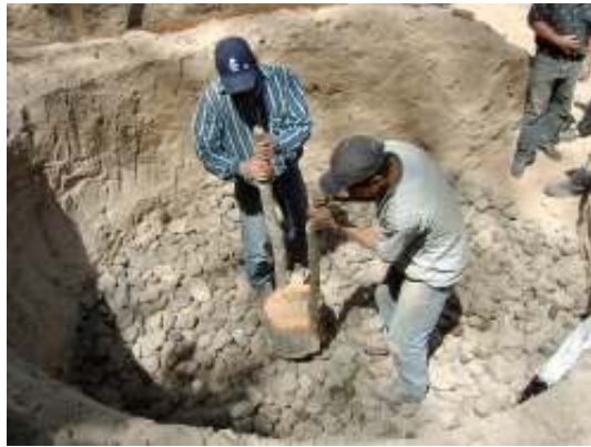
Fotografía No. 3 Recubrimiento con piedras
