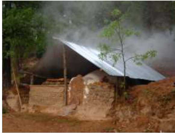
Fotografía No. 8 Techo de protección
