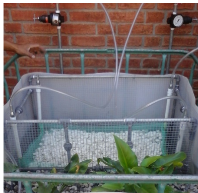
Ilustración 145: Instalación del aireador, habiendo colocado los lechos de anillos 4
