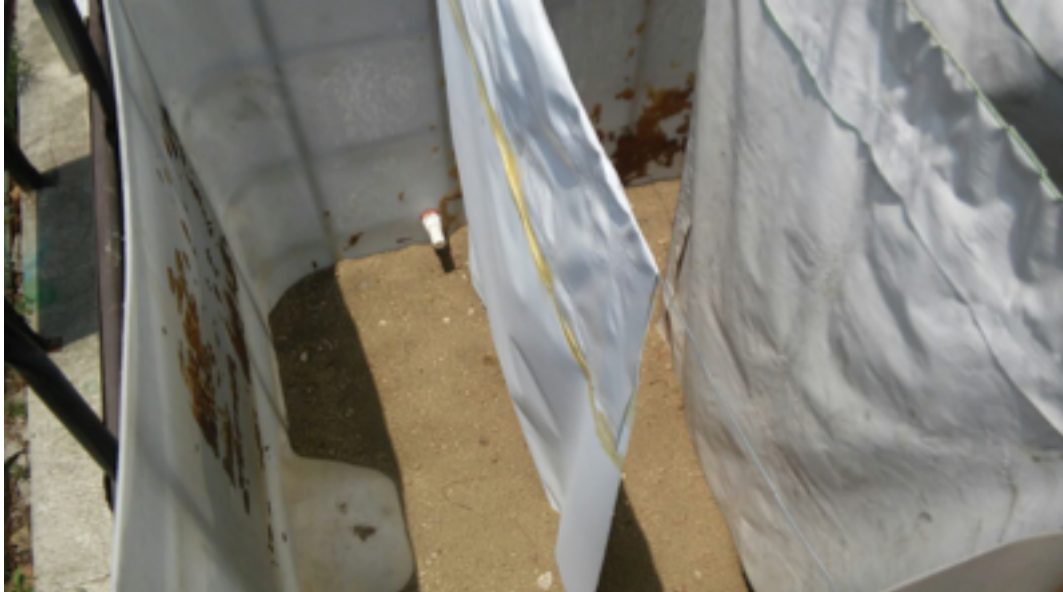
Ilustración 108: Capa de arena para rellenar el fondo de los tanques.
