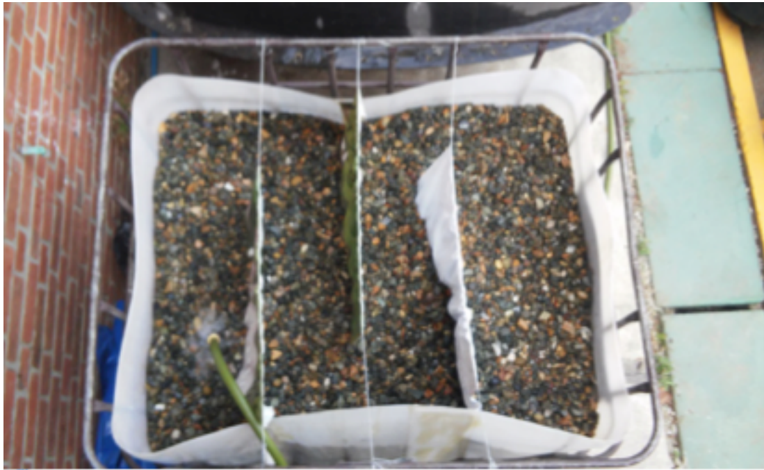
Ilustración 109: Relleno de piedrín a través de los canales de mantas vinílicas.
