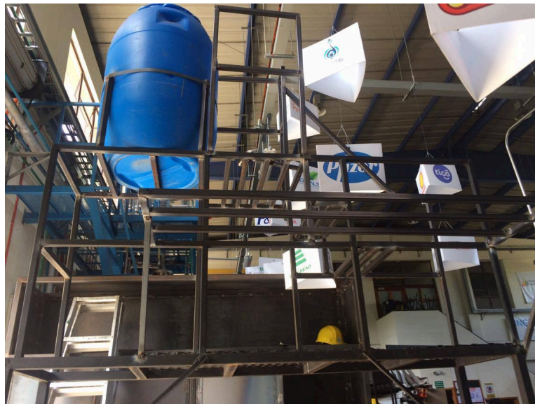
Ilustración 78: Soldadura de estructura metálica para sistema de fosa séptica
