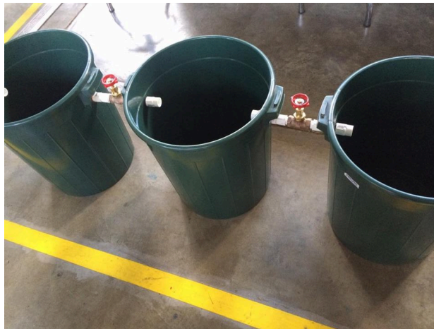
Ilustración 81: Conexión de tanques para la fosa séptica con el tanque de almacenamiento.
