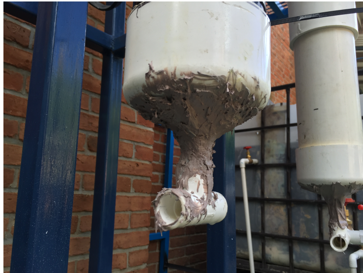
Ilustración 92: Mansilla de carro utilizada para cerrar las fugas de agua.
