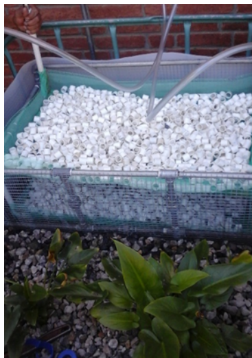
Ilustración 145: Instalación del aireador, habiendo colocado los lechos de anillos 4
