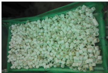
Ilustración 134: Lecho de anillos de PVC de ½ “, colocados en el aireador
