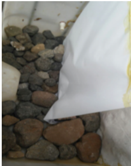
Ilustración 107: Relleno de piedras de río en el cubitanquedespués de la colocación de mantas.
