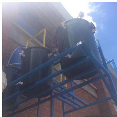
Ilustración 81: Conexión de tanques para la fosa séptica con el tanque de almacenamiento.
