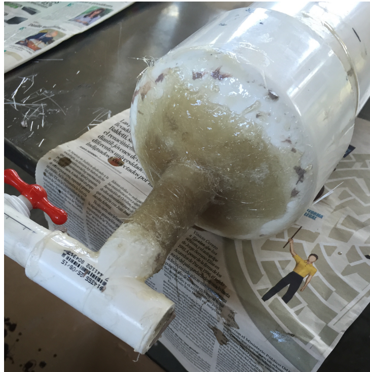
Ilustración 95: Aplicación de la fibra de vidrio para sellar fugas.
