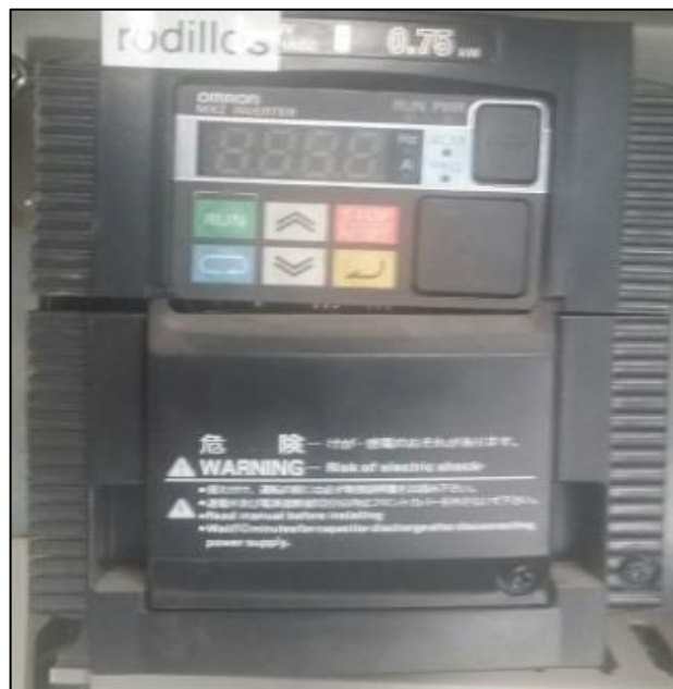
Figura 29. Variadores de frecuencia utilizados
