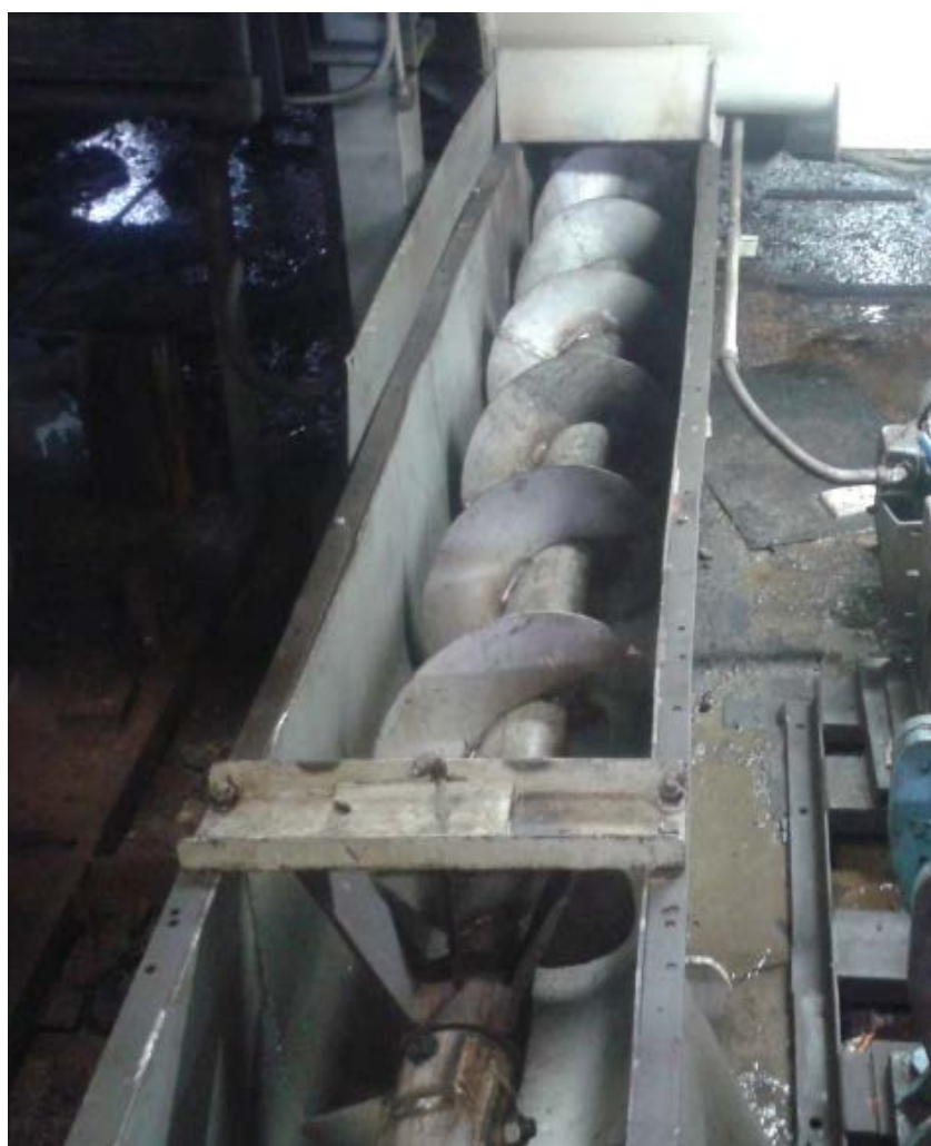
Ilustración No. 19 Transportador helicoidal en mantenimiento
